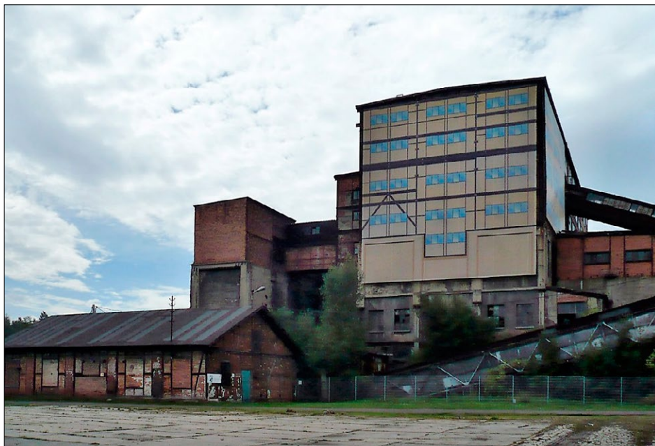
Fot. 11. Budynki służące obróbce węgla, do tej pory niepoddane renowacji i adaptacji, widok od strony ulicy Wysokiego
