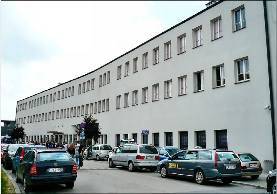
Fot. 17. Budynek administracyjny fabryki Emalia, widok od strony ulicy Lipowej
